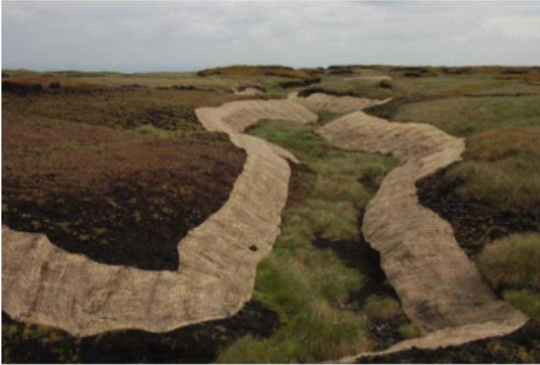
(図2)ガリの両岸の露出泥炭を安定させるために使用されたジオ・ジュート
