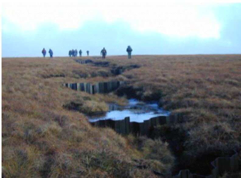
（図4）プラスチック製の積み重ねを使用した狭いガリ中のガリーブロック
