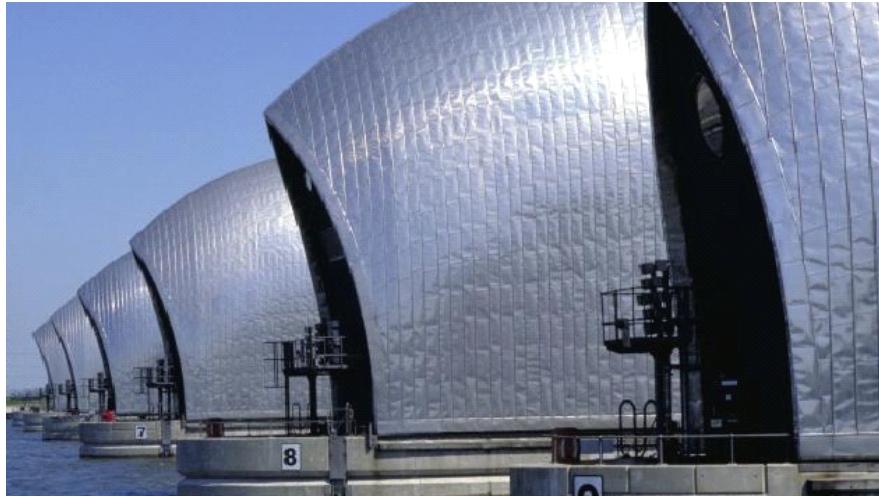
テムズバリアの回転可動堰を動かす機械室の巨大なカバー（出所：英国環境庁）
