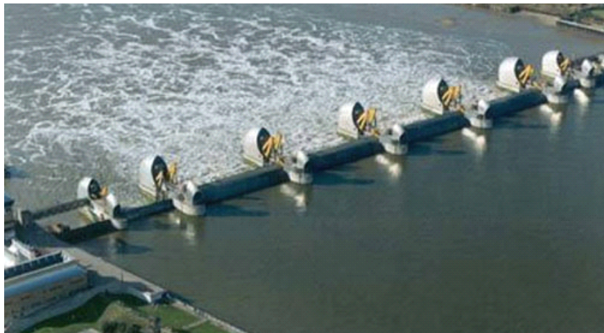
回転可動堰が半開きでテムズ川の流量調節中のテムズバリア（出所：Web）
