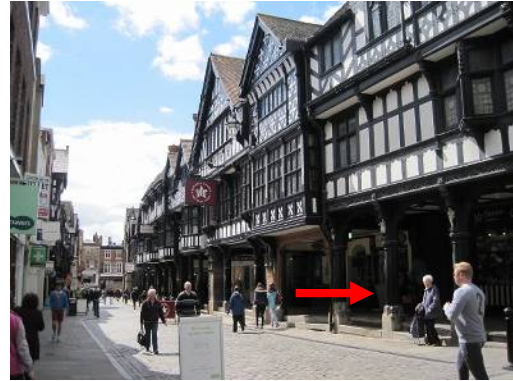
1階が通路になっているチューダー式の建物
