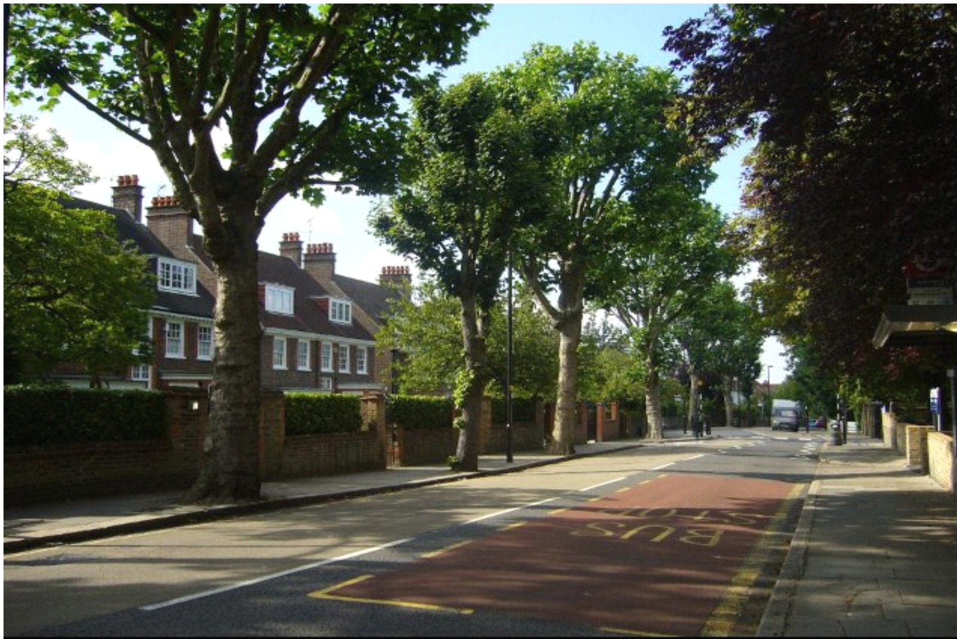
街路樹、街路灯、歩道がセットになっている住宅街
