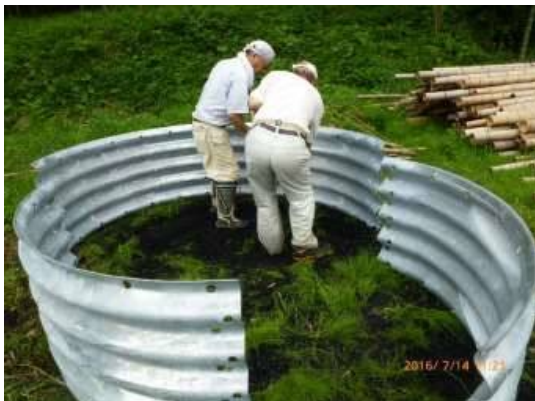
写真1・2 コルゲート板を円形に加工しカットしたものを現地で組み立てる。この組み立てにボルトとナットで締める作業に時間がかかる。炉の直径は2m。
