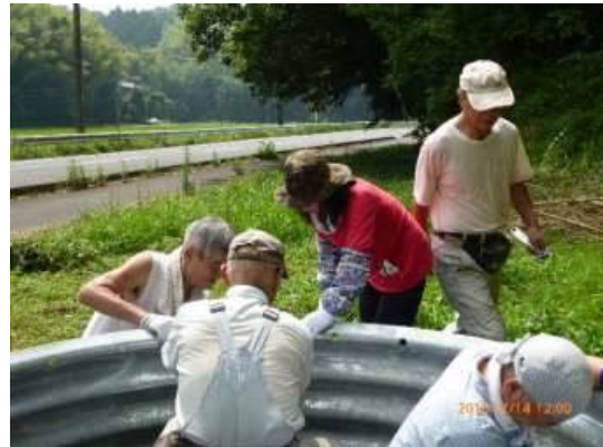
写真1・2 コルゲート板を円形に加工しカットしたものを現地で組み立てる。この組み立てにボルトとナットで締める作業に時間がかかる。炉の直径は2m。
