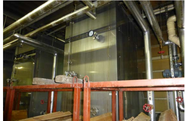
通路を挟んで反対側にある蓄熱槽
