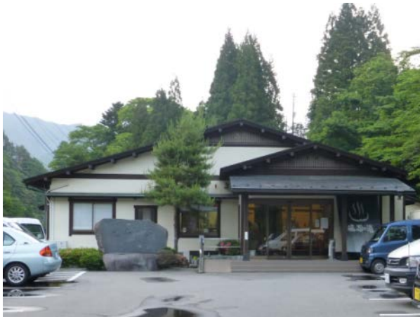
道志の湯 5台の木質バイオマスボイラーで給湯を賄っている。この右上にボイラー室がある。
