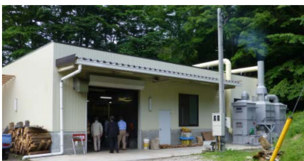
ボイラー室全景
