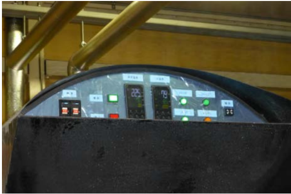
排気温 225 度、湯温 79 度
