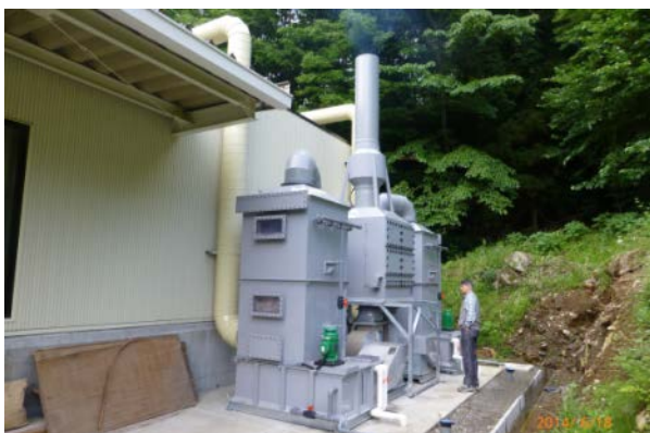
2本の排気管は、それぞれスクラバーに接続されている。排気は浄化してから大気へ放出。
