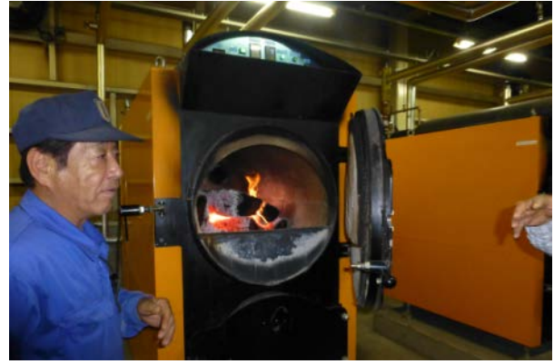
木質バイオマスボイラー
