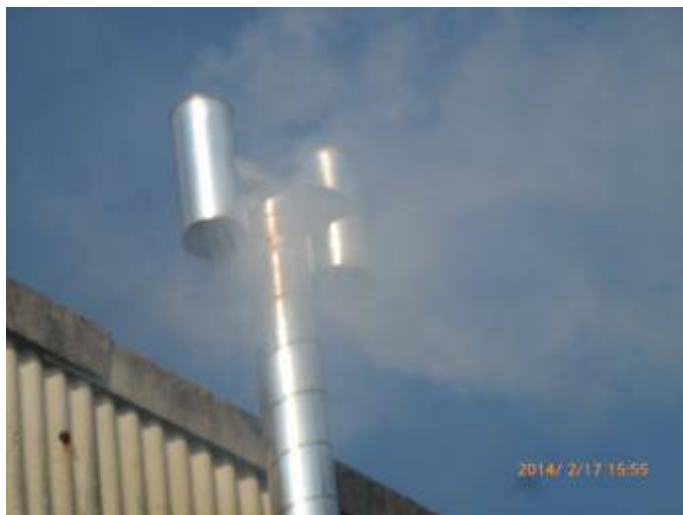
写真4 外に出てみると煙突から白煙（燃烧不良？）
