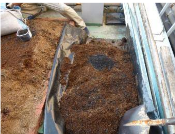
写真 16 1区画の15cm厚さを取り出して配合し、元に戻す作業の繰り返し
