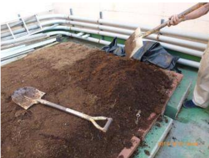
写真 21 レベル1の配合終了
