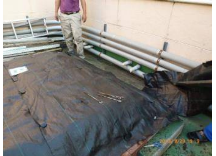
写真 24 化繊で編んだ布でカバーし、釘で固定
