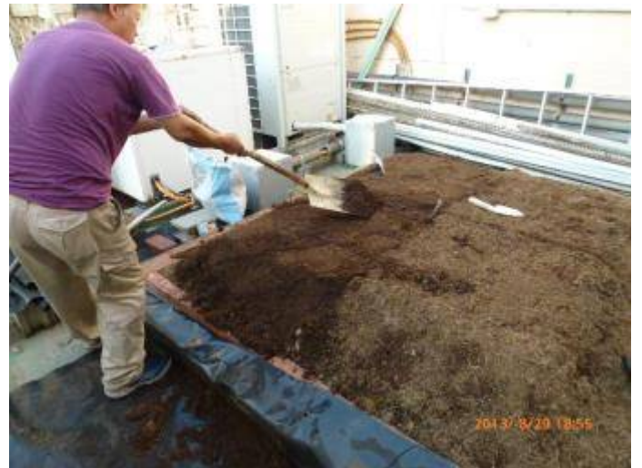
写真 20 レベル3の区域完了でソイルを固める。
