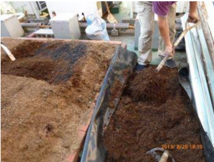
写真 19 竹炭を所定量配合して元の位置に戻す。
