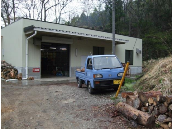
ボイラー室 (GASIFIER 設置)
