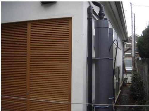
右太径塩ビパイプの雨水タンク
