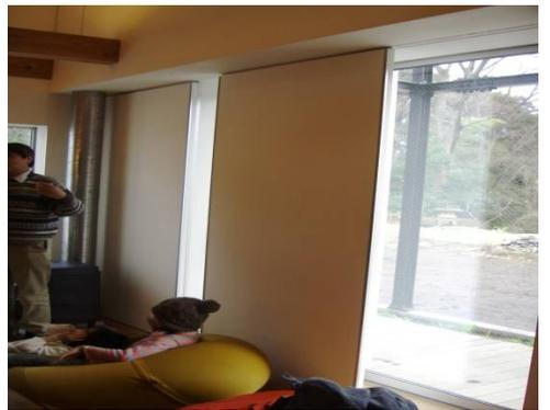
室内の輻射熱が窓から外へ出るのを防ぐ遮熱扉、適時使用する
