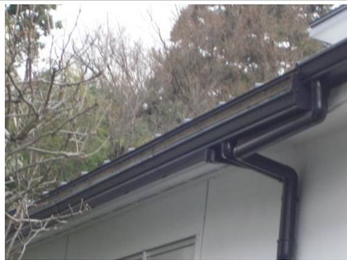
上面カバーにより落ち葉は入らないが雨水だけは表面張力で樋に入る
