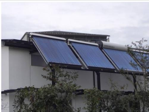
給湯は水道水、暖房は雨水を使い分けし、小型240w太陽光発電+蓄電池で運転制御をおこなう
